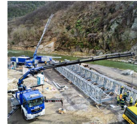
Nach der Flutkatastrophe im Ahrtal 2021 hat das THW mehr als 30 Behelfsbrücken gebaut
